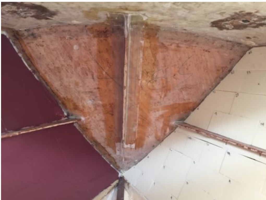
Une mosaïque de briques de mousse polyuréthane dans la cabine avant. Coupées sur mesure et numérotées...
