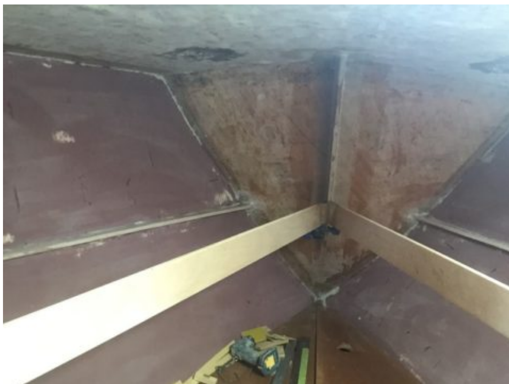
En cours d'isolation, Les lecteurs attentifs noteront que je recycle une image.
