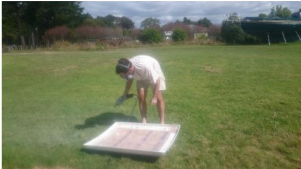
Tomtom a poncé pour préparer l'intérieur du capot, puis collé deux lattes qui serviront à tenir le système d'ouverture et de verrouillage, entre lesquelles on mettra de l'isolation.
