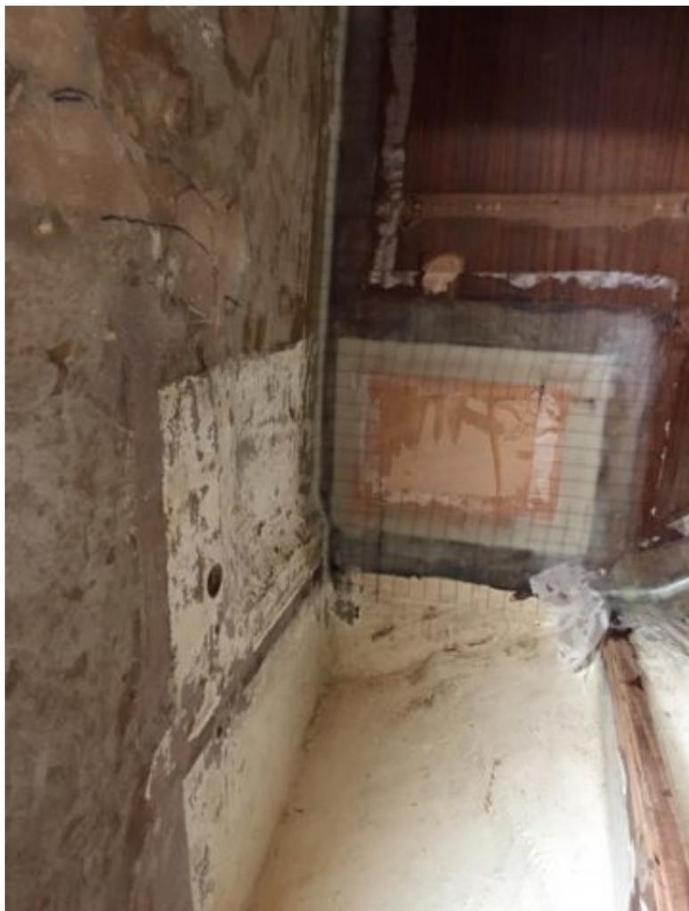
Côté table à cartes, première étape : on bouche les trous ! Le gros rectangle au fond, qui donne dans un coffre du cockpit, servait il y a des années à l'aération des batteries qui étaient sous la table à cartes. Maintenant c'est à nouveau une paroi digne de ce nom.
