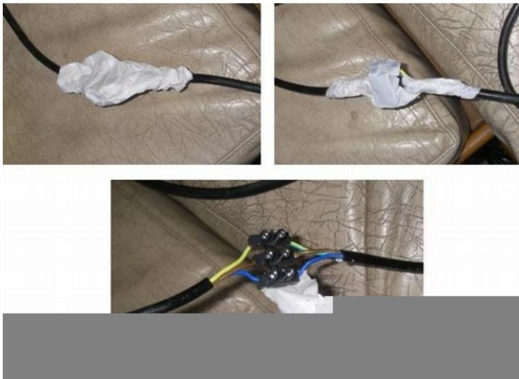
Donc, entre autres travaux, on a remplacé les liaisons « fils entortillés scotchés » ou « fils reliés par des dominos et scotchés » par des liaisons « fils entortillés, soudés, emballés dans une gaine thermorétractable ». C'est plus classe. Et ça évite aux dominos de rouiller dans un environnement mouillé et salé.
