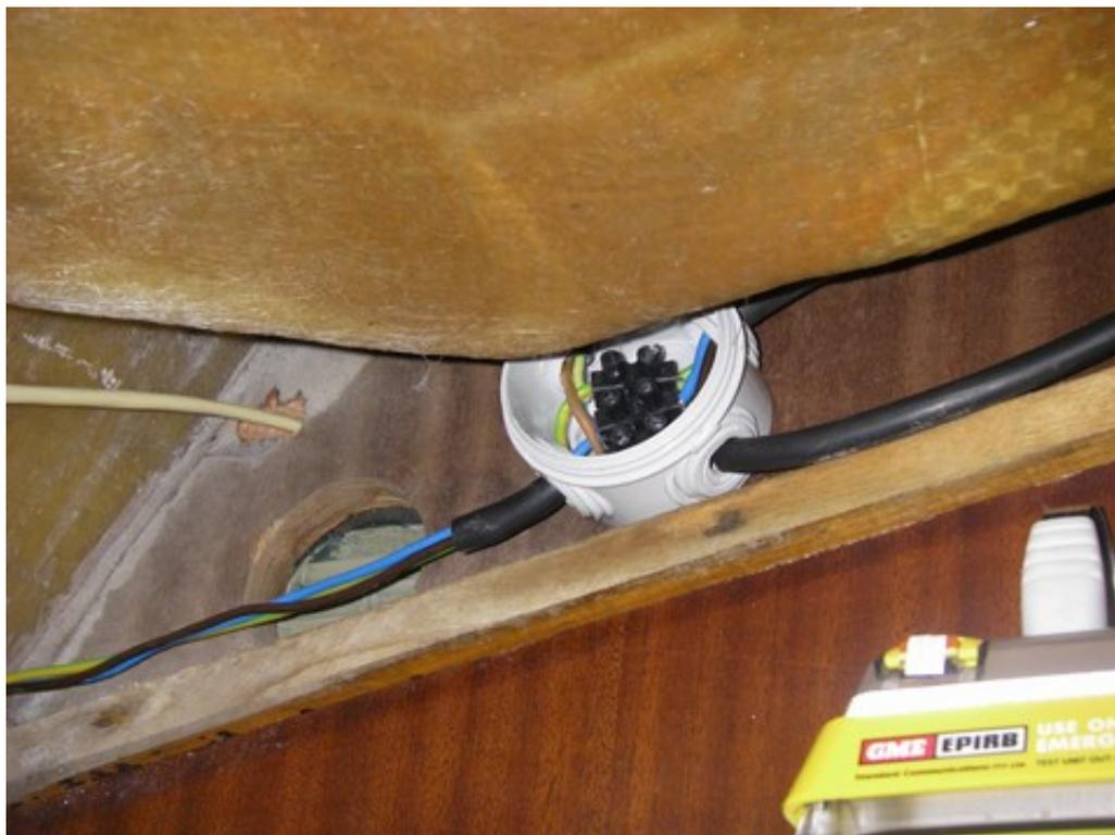
Au passage, plusieurs modifications bien pratiques : remplacement de la prise du chauffe-eau par un interrupteur, permettant de l'arrêter facilement sans devoir ouvrir le coffre arrière, et ajout d'un autre interrupteur pour commander la mise sous tension d'une prise destinée à la cuisine, tout ça pour ne pas avoir à débrancher la mini-table à induction (voui voui, comme à la maison, encore !!) à chaque fois.
