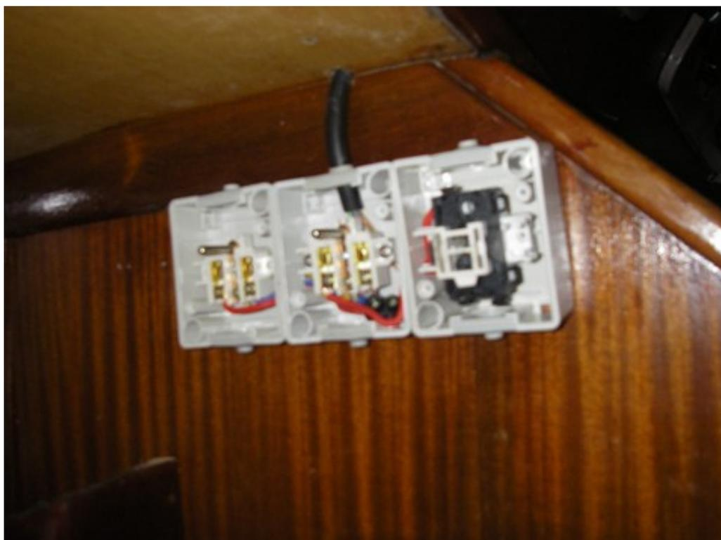
Tout cela a fini par le raccordement au tableau électrique, à la mise sous tension et ... à la coupure d'électricité de tout le quai lors de la commutation du chauffe-eau ... **Résistance foutue** (résistance bouillue ?) ...
