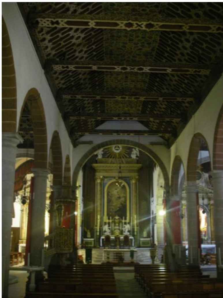
Charpente de l'église de El Salvador, un des plus belles des Canaries
